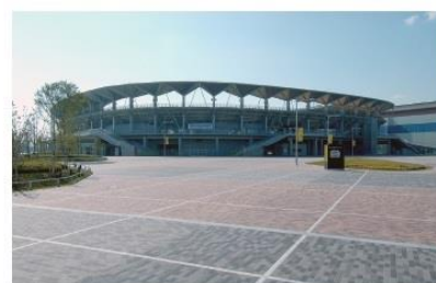
建設中のフクダ電子アリーナ
